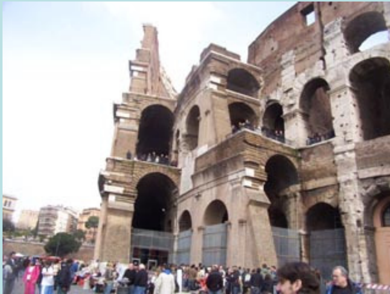
Vista exterior, distintos niveis de conservación de fora cara dentro
